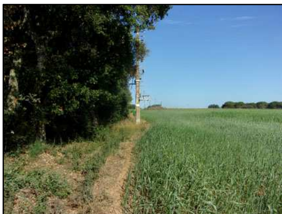
24. Vista des del sud-est del punt de connexió amb la xarxa elèctrica a l'extrem sud-est del Sector 7.
